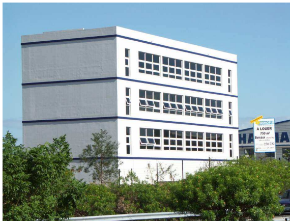
Figure 1: Un contre-exemple parfait en matière de conception thermique de bâtiment en climat tropical. La façade vitrée sans protection est une façade Est.
