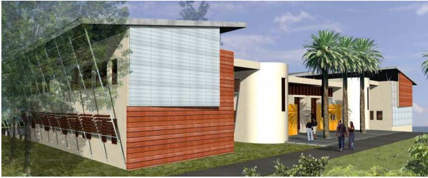
Figure 4 : Vue des façades nord (protections solaires en lame de bois) et ouest (bardage tôle et bois).
