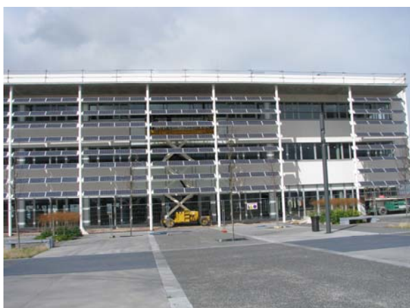
Figure 2 : Panneaux photovoltaïques utilisés en brise-soleil (dimensions calculées suivant TRNSYS).
