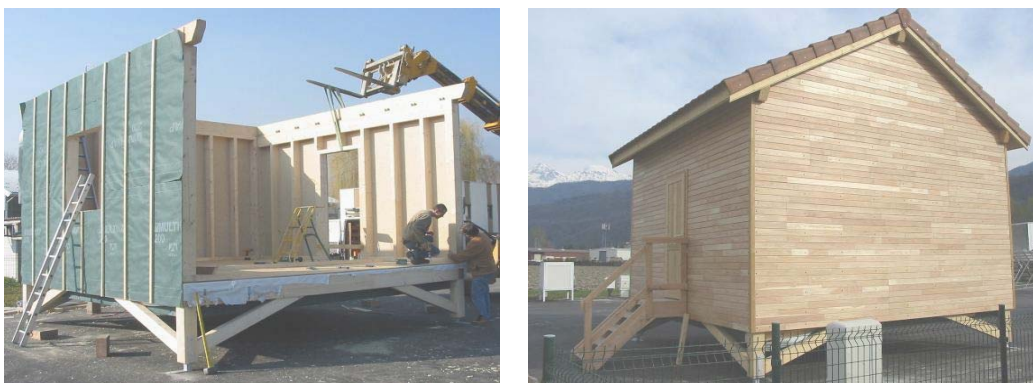
Figure 1 : Photographies de la cellule-test « OPTI-MOB ».
