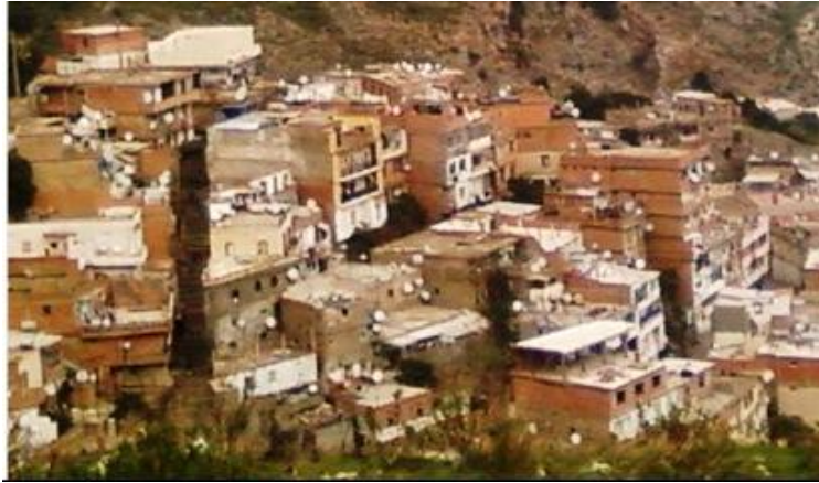
Figure 1. Constructions en milieu urbain dense sur terrain accidenté -photos prise par l'auteur-
