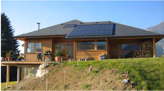
Figure 2 : vue de la façade Est de la maison
