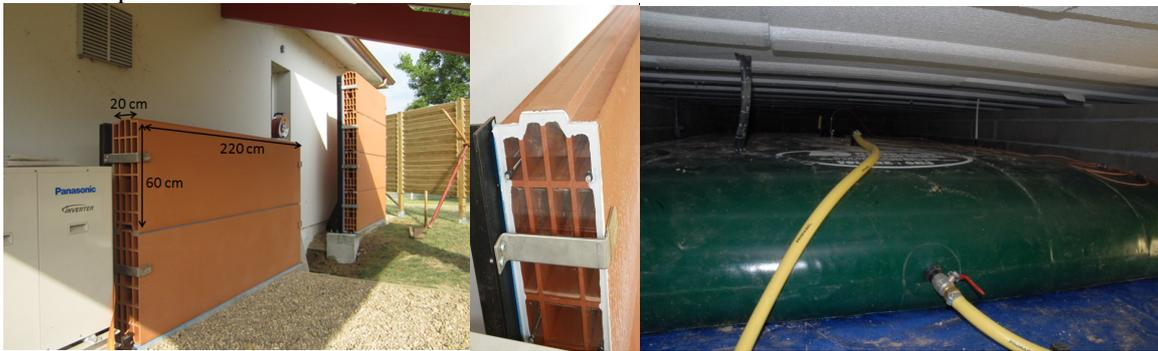
Figure 3 : Illustration des briques (évaporateur), à gauche en cours de montage, au centre en détail avec les bouchons de fermeture, et d'une citerne de stockage, pleine et raccordée (à droite).
