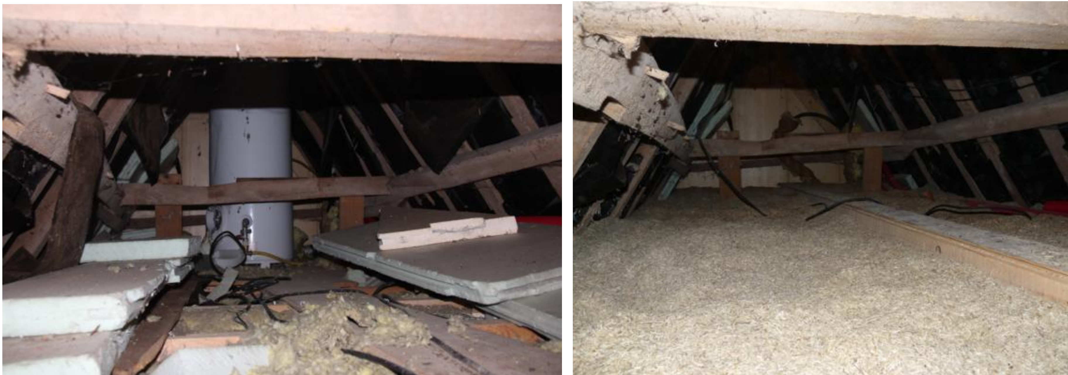
Figure 3 : Grenier avant et après rénovation.
