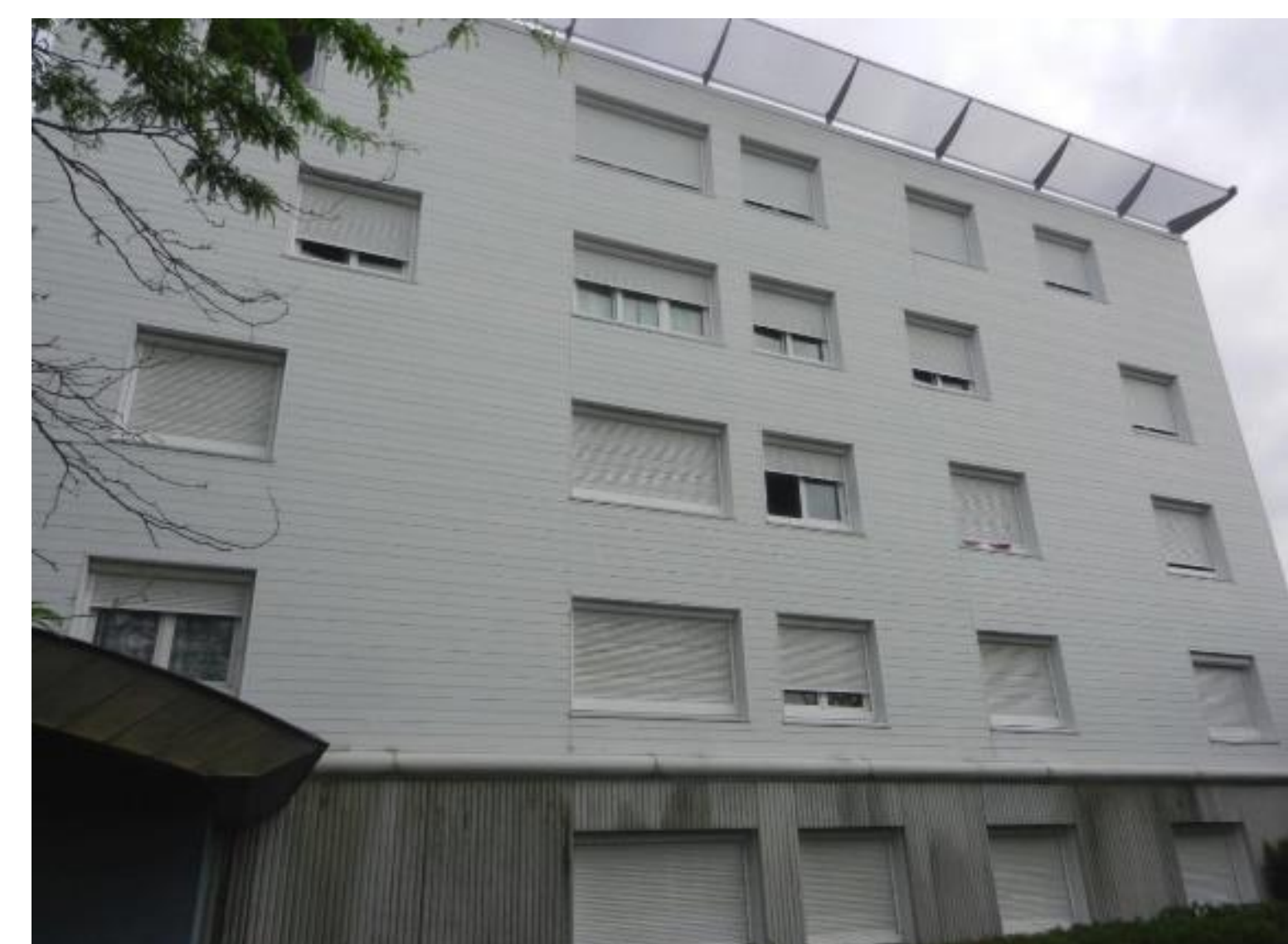
Figure 3: Photo de la façade ouest du bâtiment central
