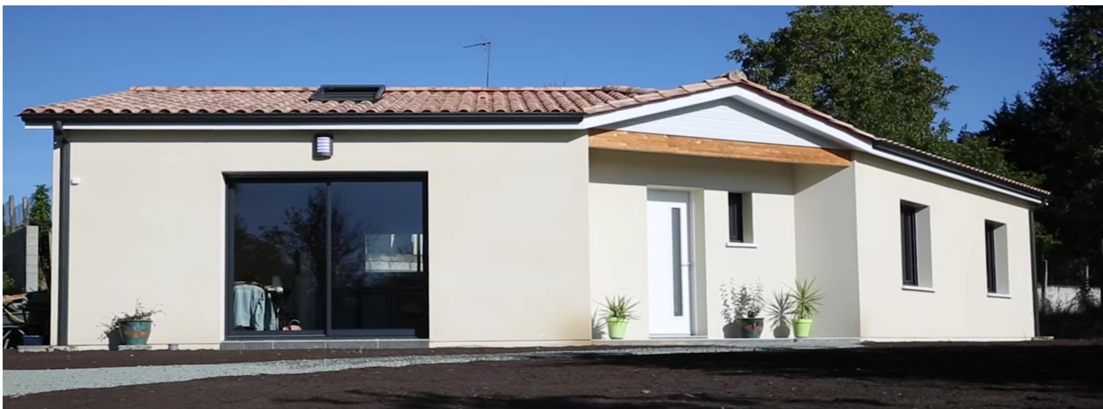
Figure 2 : vue Sud de la maison COMEPOS étudiée
