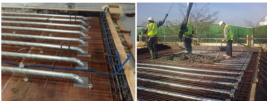
Figure 1 : Photos des gaines de ventilation avant et pendant coulage de la dalle de béton
