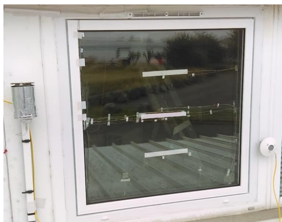
Figure 1 : Fenêtre instrumentée en façade sud d'un bâtiment de la faculté à Béthune
