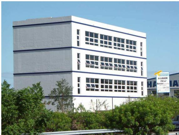
Figure 1: Un contre-exemple parfait en matière de conception thermique de bâtiment en climat tropical. La façade vitrée sans protection est une façade Est.
