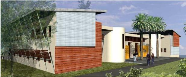
Figure 4 : Vue des façades nord (protections solaires en lame de bois) et ouest (bardage tôle et bois).
